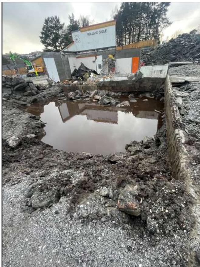
UTSLIPPSFRI BYGGEPLASS: Kommunen tester ut nye klimaløsninger når det bygges skole på Rolland i Åsane. Foto: Lars Mortensen
