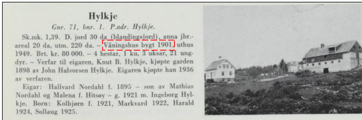
Fig.25: Hylkje, dagens gnr. 171, bnr. 1, status for gården i 1964. Rød utheving indikerer alder på bygning som fortsatt står i dag (Kilde: utklipp fra «Norske Gardsbruk»).
