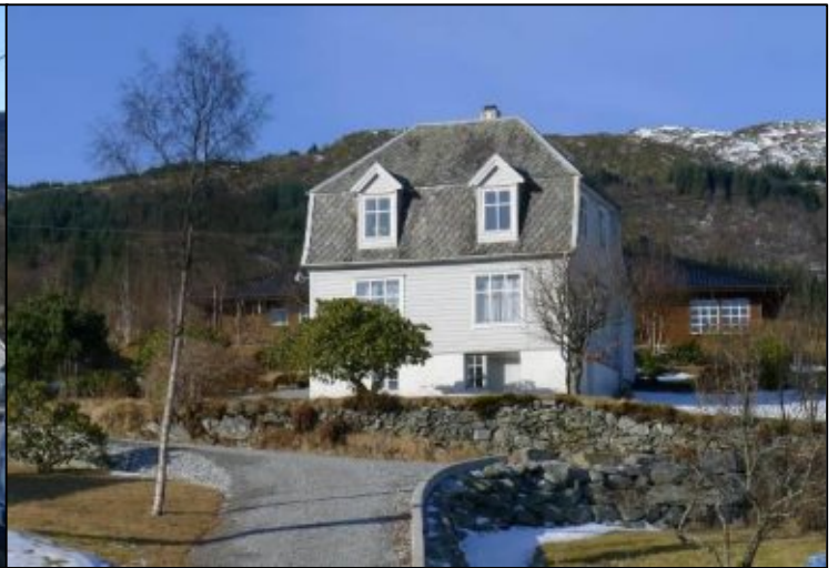
Fig.42: Hylkjevegen 28, reist i 1924. Nybarokk, halvvalmet mansardtak tekket med skifer (Kilde: Bergen kommune, Byantikvaren 2013).
