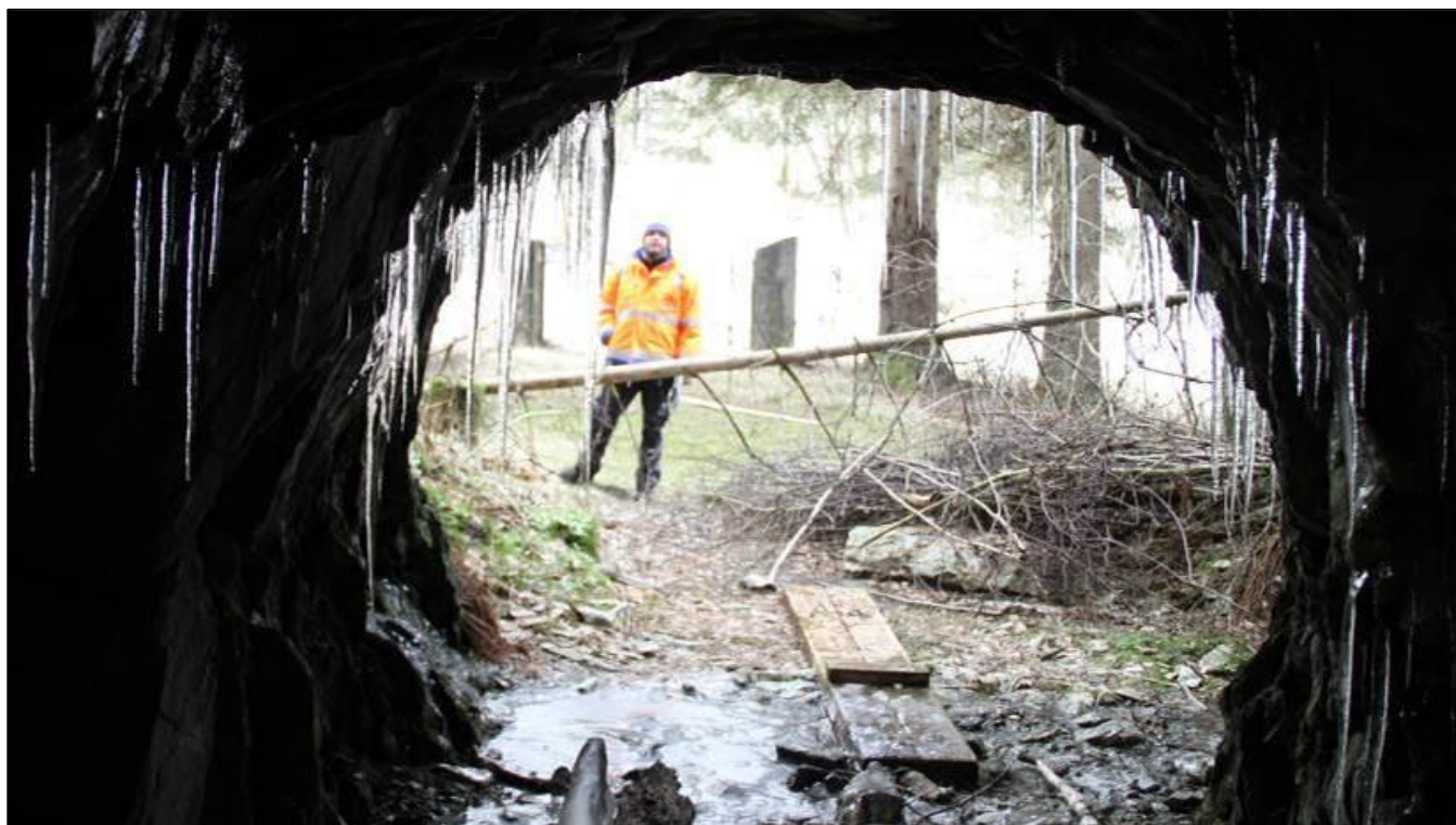
Fig.5: Observasjoner i felt på Hylkjeneset. Bilde inne fra en tunnel som trolig har utgjort en del av det tyske forsvarsverket på neset (Kilde: Bergen kommune, Byantikvaren 2013).
