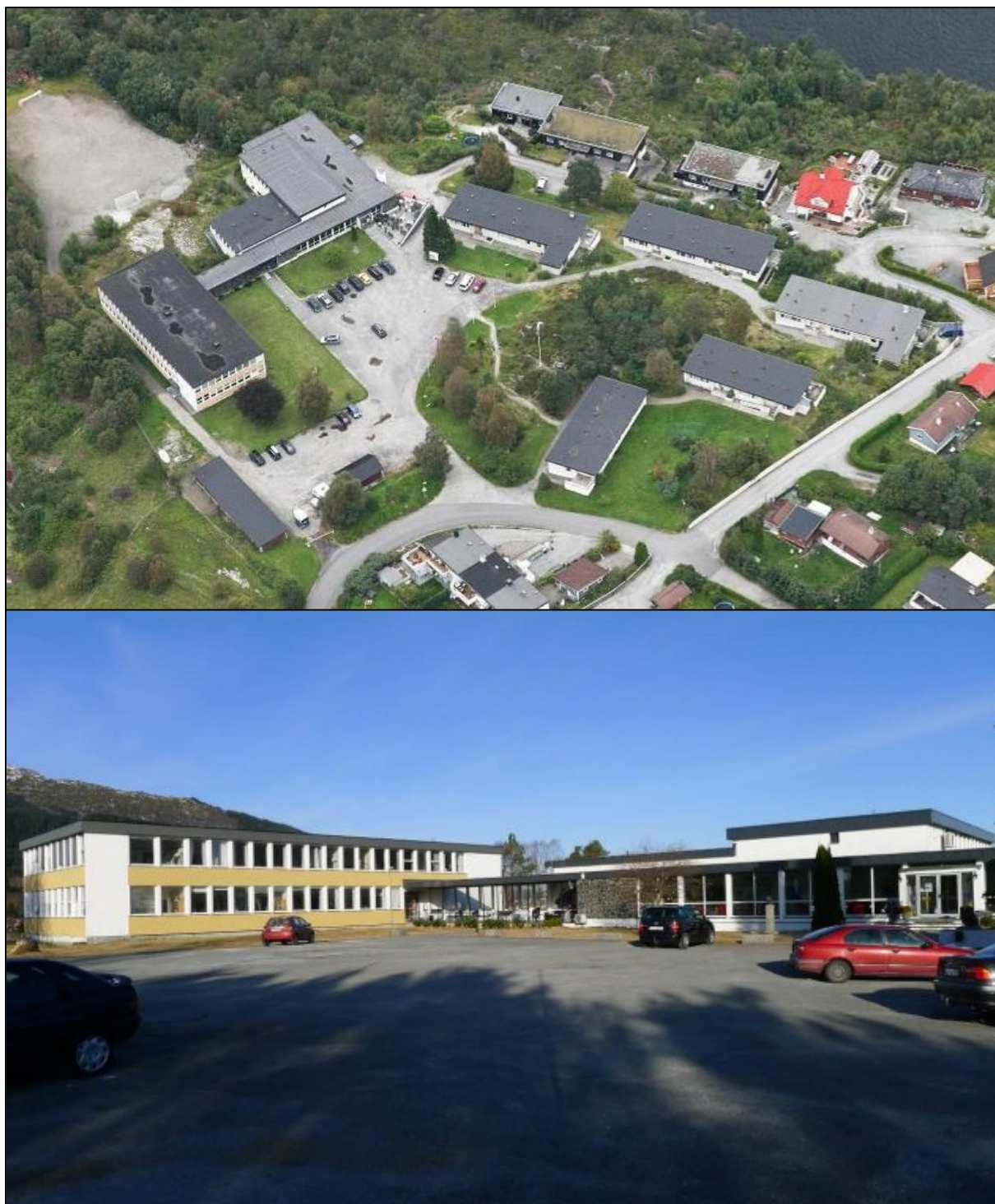
Fig.47: Over: flyfoto av Åsane folkehøgskole. Selve skolebygningen til venstre, med internatbyggene til høyre (Kilde: Bergen kommune 2012). Under: foto av Åsane folkehøgskole (Kilde: Bergen kommune, Byantikvaren 2013).
