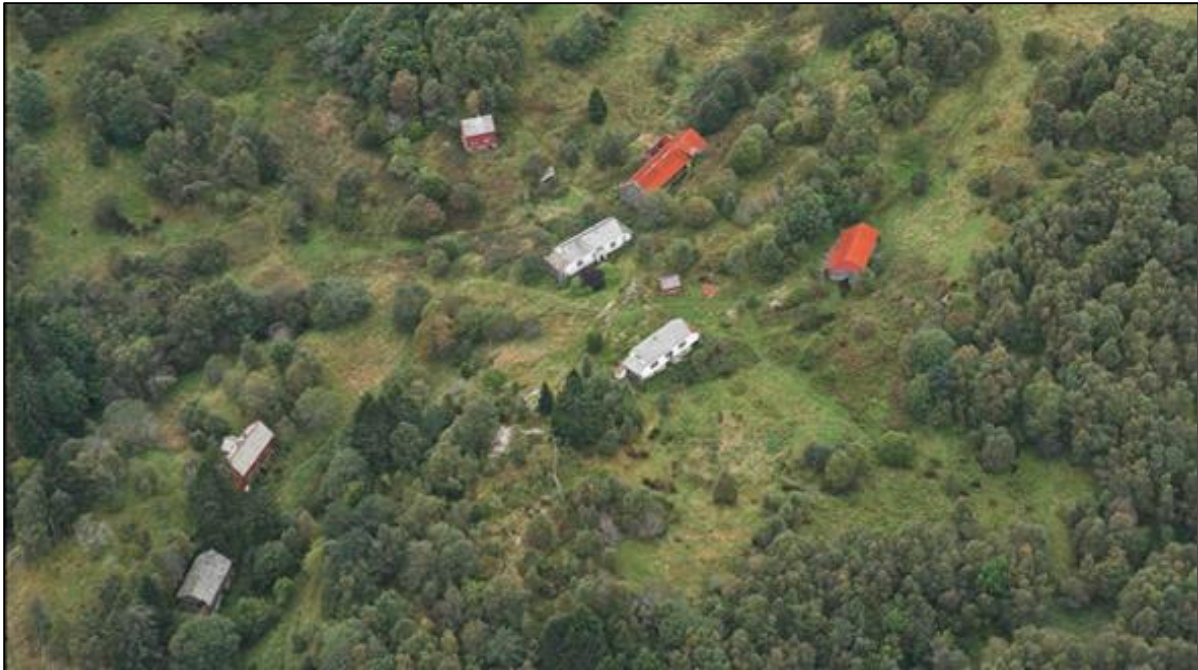
Fig.4: Flyfoto over Almås gård viser en serie enkeltobjekt som til sammen danner et godt bevart verneverdig kulturmiljø (Kilde: Bergen kommune 2012).
