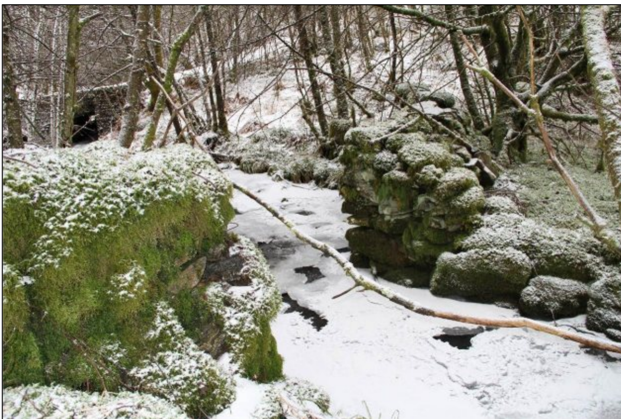
Fig.63: Steinkonstruksjon i bekk på Almås, bnr. 181 (Foto: Bergen kommune, Byantikvaren 2013).
