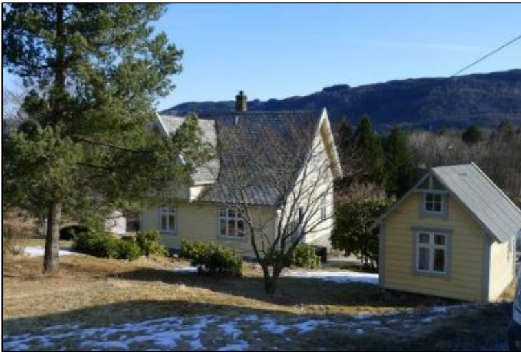
Fig.41: Hylkjevegen 33, skal være reist i 1921. Trebygning med saltak og stor ark tekket med skifer. Bygget i tradisjonell stil på naturtomt, med to uthus (Kilde: Bergen kommune, Byantikvaren 2013).
