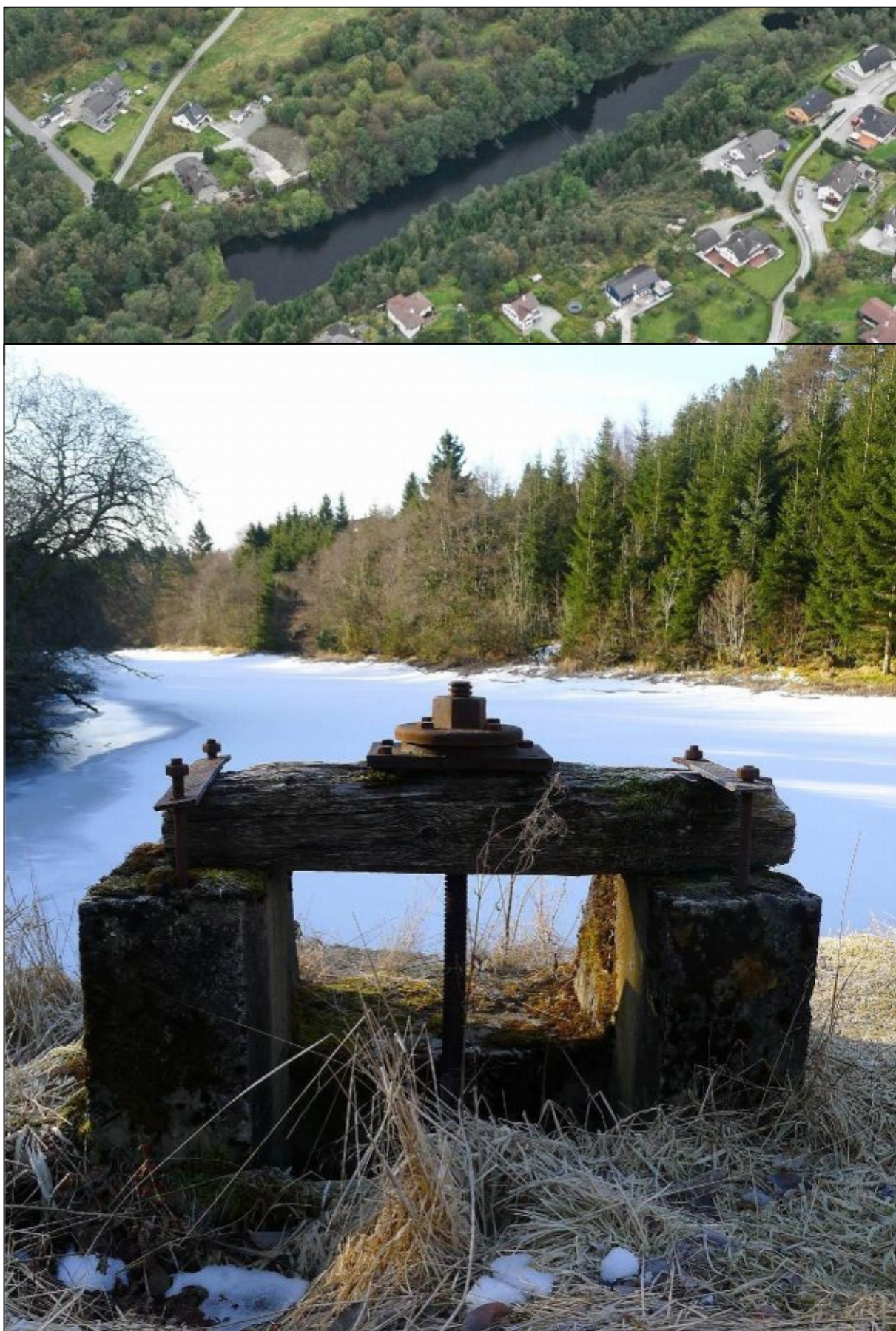
Fig.40: Over: Flyfoto av Hylkjestemma fra 2011. Under: Innordning for å justere vanntilførsel (Kilde: Bergen kommune, Byantikvaren 2013).
