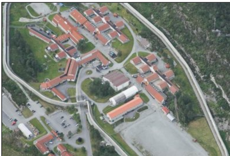
Fig.49: Flyfoto av Bergen landsfengsel (Kilde: Bergen kommune 2012).
