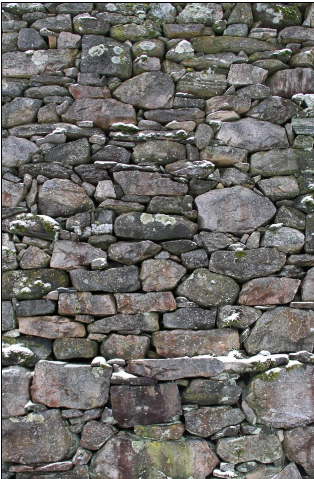
Fig.1: Del av tørrmurt gavlvegg på Almås gård, bnr. 1 (Kilde: Bergen kommune, Byantikvaren 2013).
