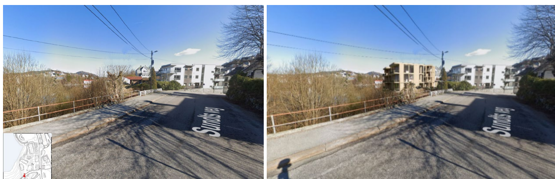
Figur 31 Før og etter, fra Sundts veg, mot nordvest. Bygg A.
