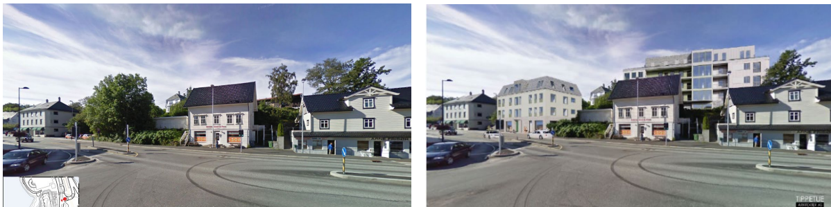
Figur 28 Før og etter sett fra øst, mellom terminal og Nesttun senter, mot sørvest. Bygg D til høyre. Bygg C til venstre, langs Nesttunvegen.
