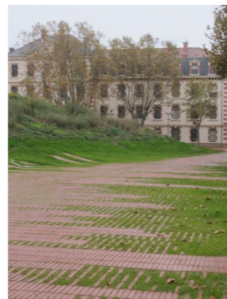
Prinsipppløsnings 2: Overgangen mellom torg og kjørebane. Møte mot urbane byrom i øst.
