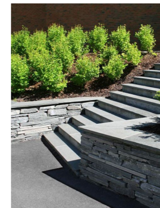
Prinsipppløsnings 4: Det skal benyttes gode materialer i trappelagg og på murer. Eksempelvis granitt eller skifer.
