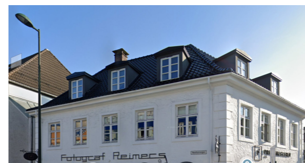
Nesttunvegen 104- skrånet tak mot gateløp
