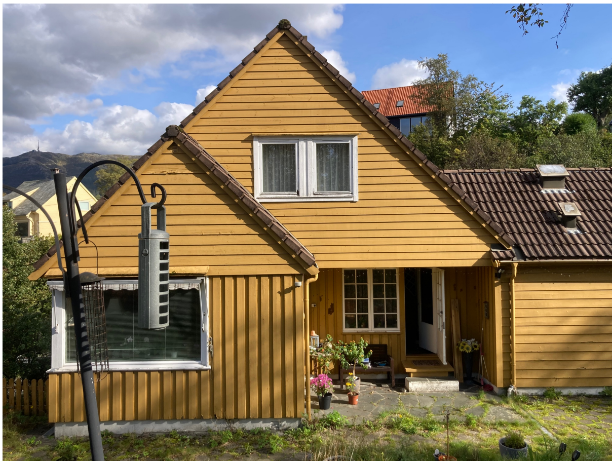
Nordre del av sørvestfasaden, med inngang til 1. etasje.
