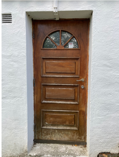
Kjellardør i nordvestfasaden – fører inn i vaskekjellaren.
