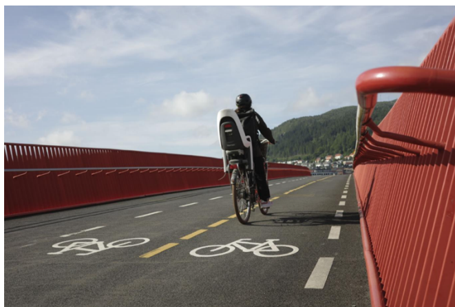
Figur 6-3 - Eksempel på oppmerket separasjon av gående og syklende på Nonnekloppen. Tilsvarende enkel separasjon kan være et aktuelt grep i fase 1 fram til hovedsykkelruten flyttes ut på banebroen (foto: Margrethe Vikan Sæbø)
