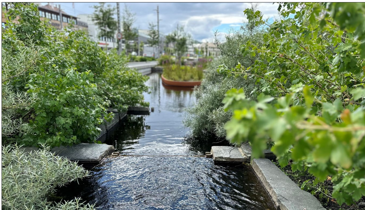
Figur 1-1: På Mindemyren i Bergen er det bygd en todelt kanal, med en øvre del og en underliggende flomkanal. Gjennom denne løsningen oppnår en nødvendig sikkerhet mot flom, samtidig som en får en attraktiv kanal med åpent vannspeil på overflaten. Foto: Trude Haugen, Bergen Vann
