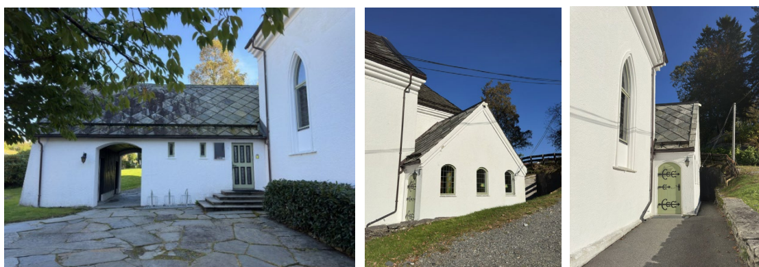
Figur 41. Bilde til venstre viser tilbygget til kirken i nord fra 1960-tallet. Bilde i midten og til høyre viser dagens sakristi mot sør, der det nye tilbygget er planlagt forbundet med et «mellombygg».
