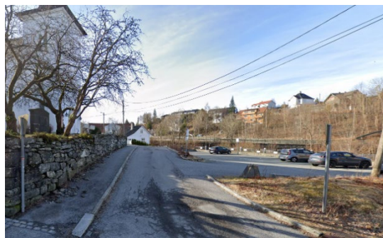
Situasjon KV. 31830 Hardangervegen.
