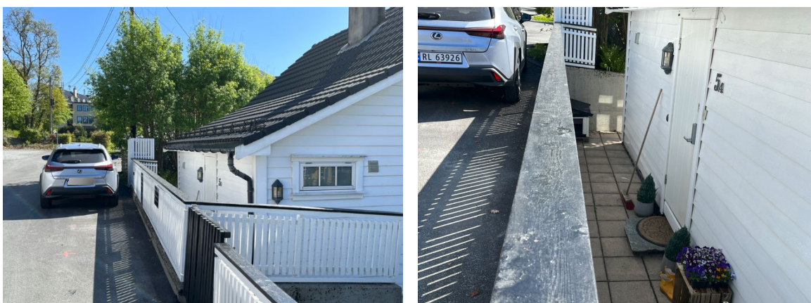
Figur 55. Foto som viser dagens situasjon ved inngangen til Hv. 5A med mur og gjerde mot vegen.
