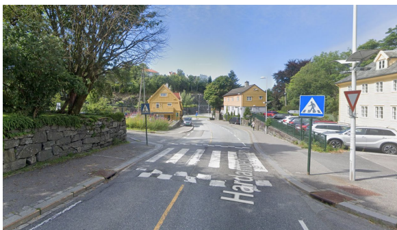
Situasjon FV. 5196 Hardangervegen.
