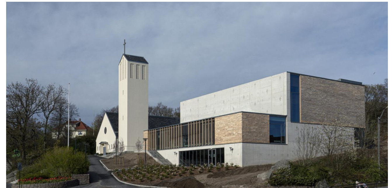
Figur 29. Flekkerøy kirke med påbygg
