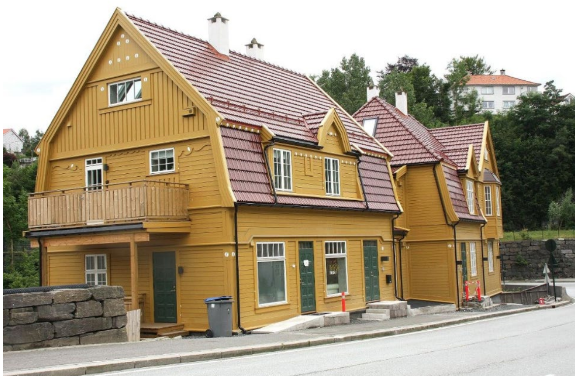
Figur 40. Hardangervegen 1 og 3, bildet fra Fanaposten.
