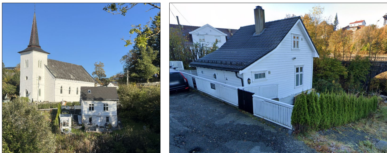
Figur 33. Hardangervegen 5A. Vestlig fasade til venstre og nordøstlig fasade til høyre.
