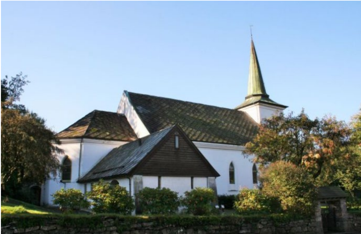
Figur 22. Birkeland kirke, nordlig fasade.
