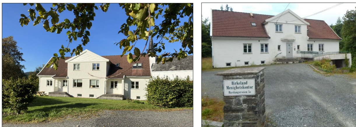
Figur 31. Menighetskontoret, sørlig fasade til venstre. Nordlig fasade til høyre.
