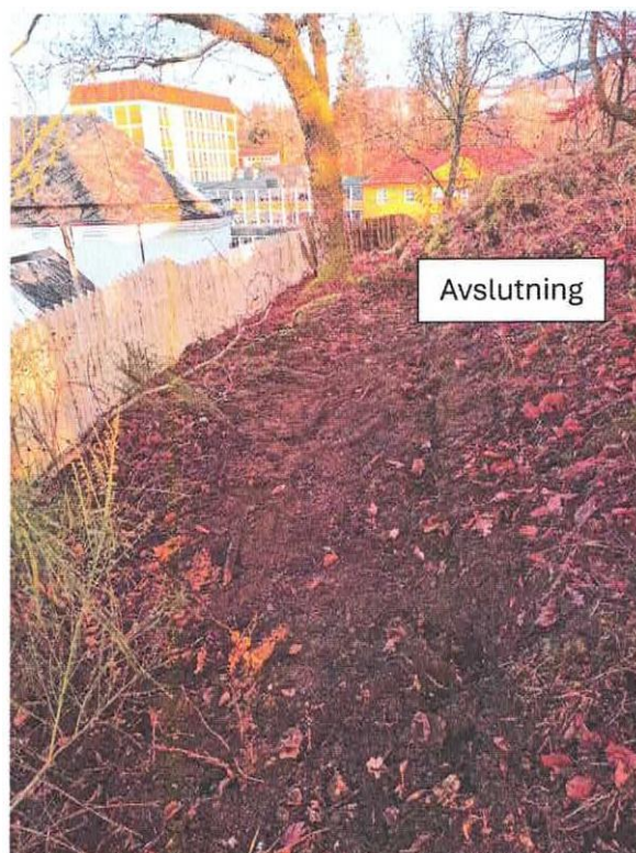
Avslutning avgrøft, tildekket.
