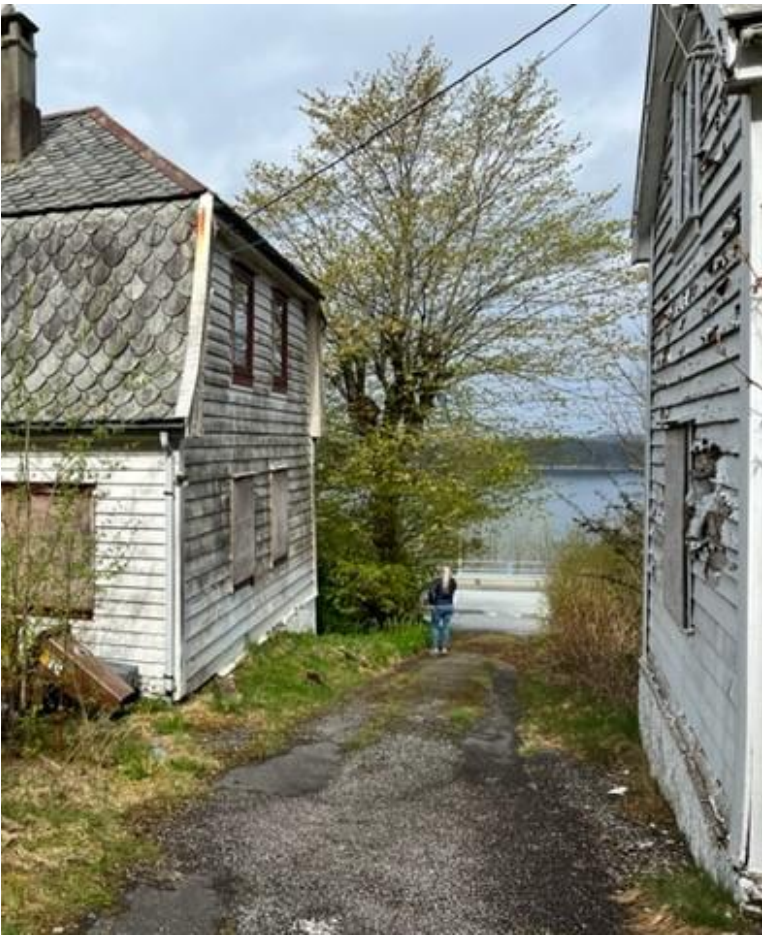
Inngang til tun i eksisterende bebyggelse
