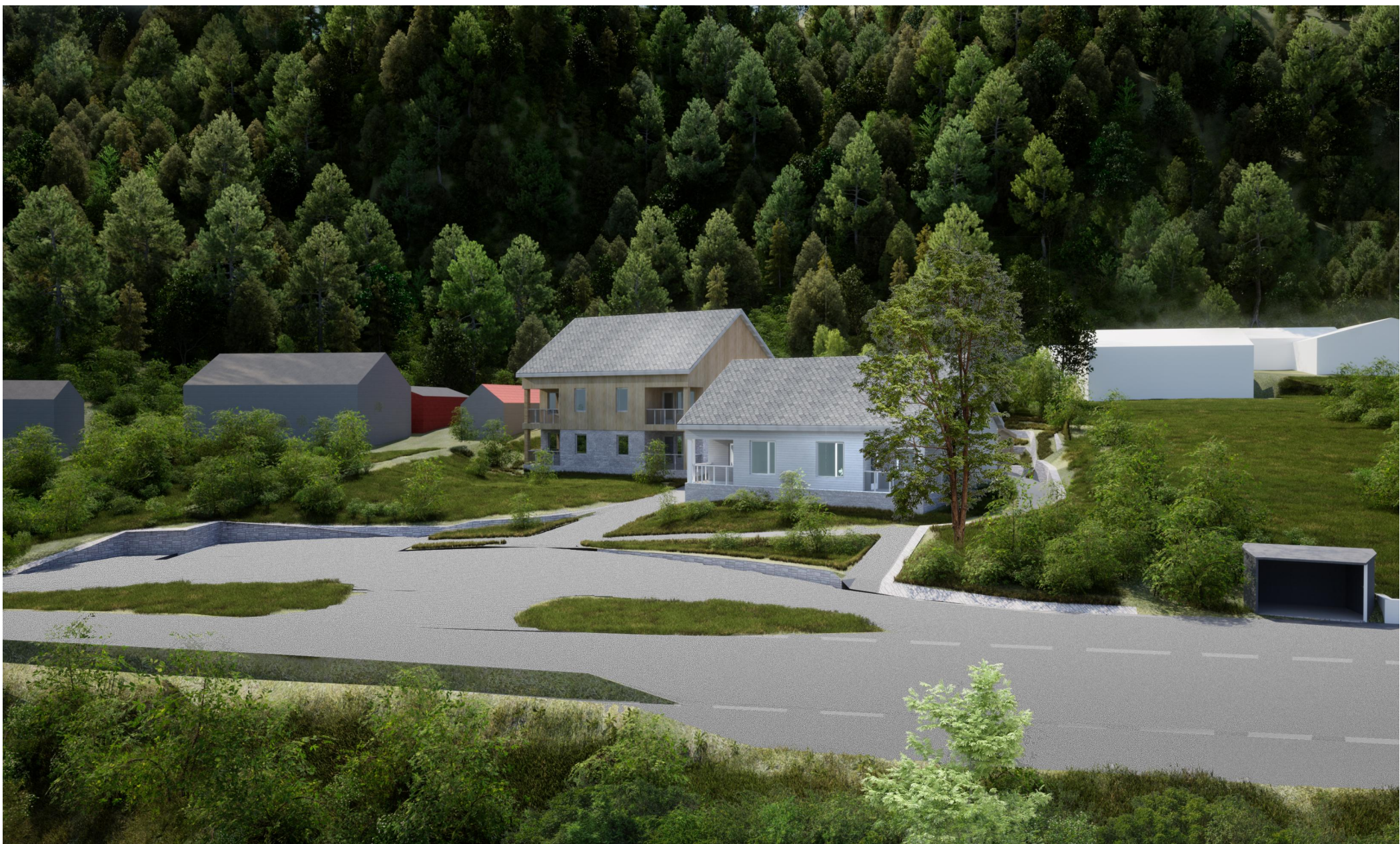
3 Oversiktsbilde sett mot øst/Krokeidevegen
