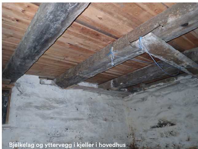
Soppvekst på alle overflater i hovedhus.
