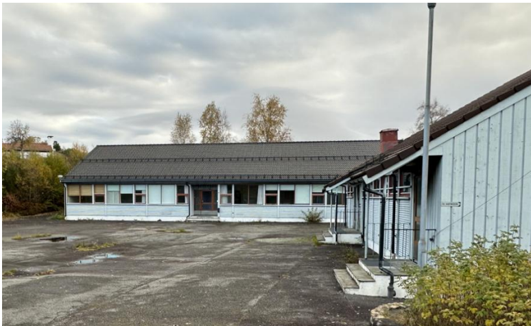
Figur 9: Eksisterende bygg i nord.
