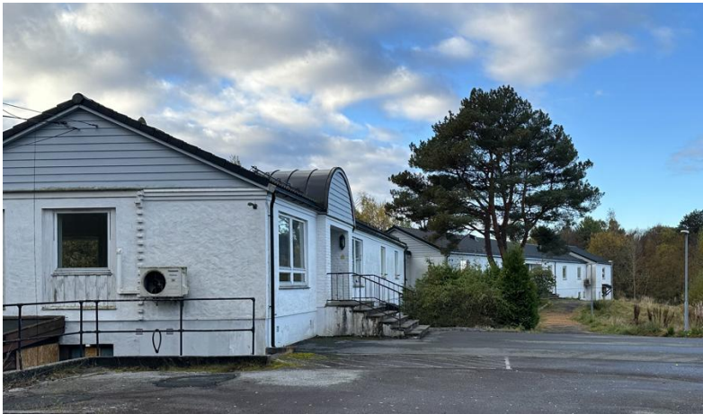
Figur 8: Eksisterende bygg i sør.
