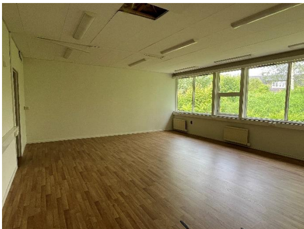
Figur 4-89 Klasserom i nordøstre hjørne av bygget.
