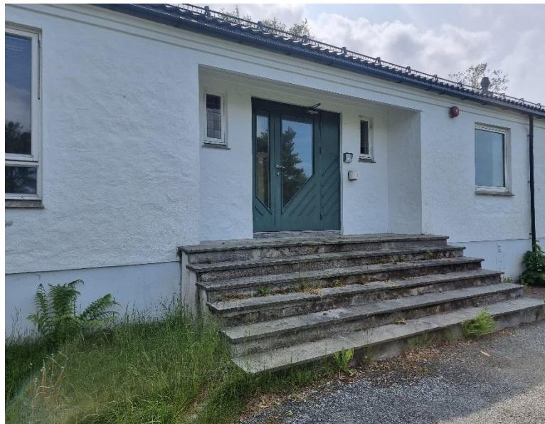
Figur 4-13 Inngangsparti i sørvest. Denne inngangen var opprinnelig brukt som inngang for beboerne på internatet.
