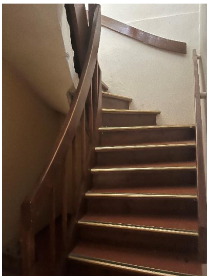
Figur 4-49 Trappegang fra kjøkken til tidl. skolekjøkkenet i kjelleren.
