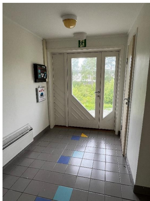
Figur 4-47 Inngang i sørvest, brukt som adkomst for beboerne
