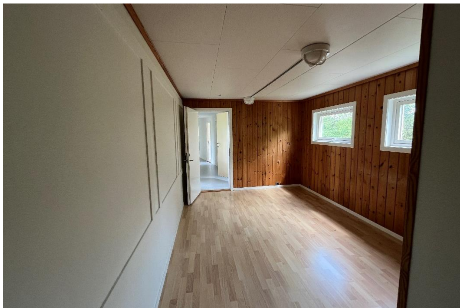
Figur 4-45 Fra gangen (passasjen) mellom paviljongene. Her har det vært en «luftebalkong» som siden har blitt kledt inn (jf. Figur 4-3 og Figur 4-5).
