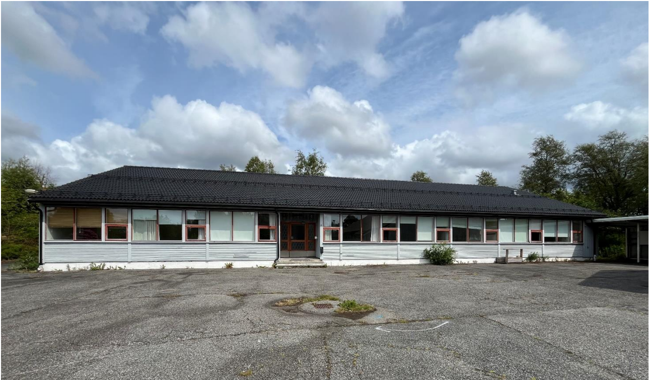
Figur 4-83 Fasade mot sørvest. Bilderetning Ø.
