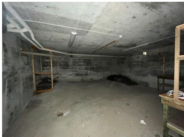
Figur 4-78 Fra indre del av kjeller under gymsalen
