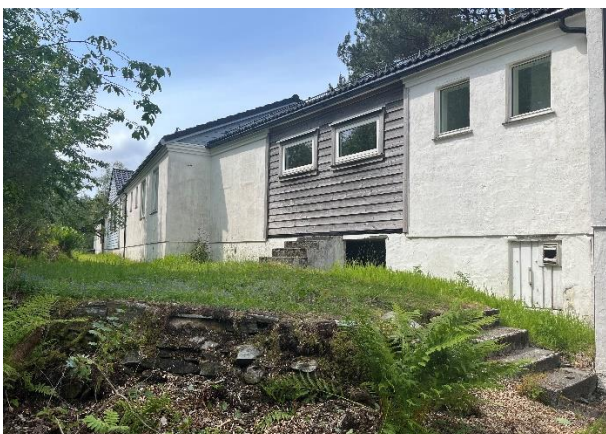
Figur 4-18 Fasade mot sørøst. Midt i bildet går passasjen mellom de to paviljongene. Her var det oppr. en åpen «luftebalkong», som siden har blitt kledt inn bak trepanelet. Bilderetning V.
