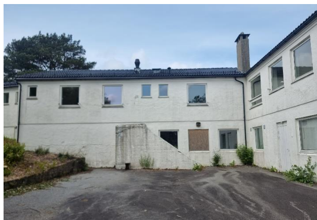
Figur 4-19 Fasade mot sørøst. Bak den skrå leveggen går en dør inn til tidligere vaskerom i kjelleren.
