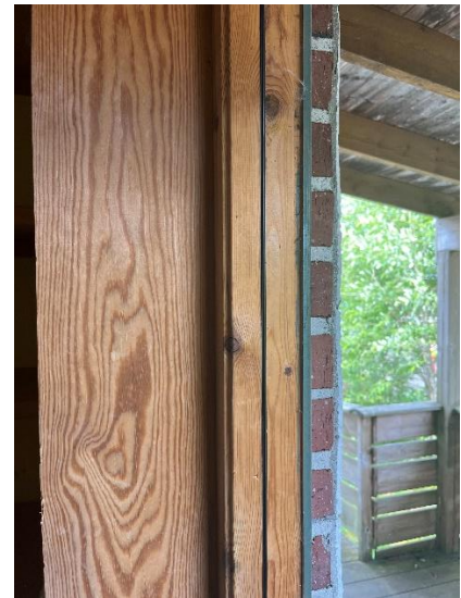
Figur 4-33 Detalj av tegl i fasade mot øst ved kjøkkenutgang.
