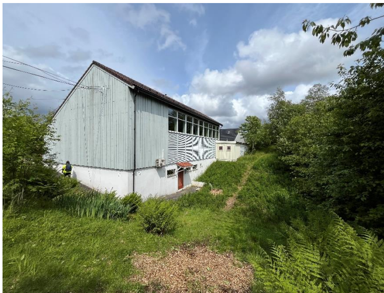
Figur 4-67 Fasade mot sør og øst. Bilderetning N.
