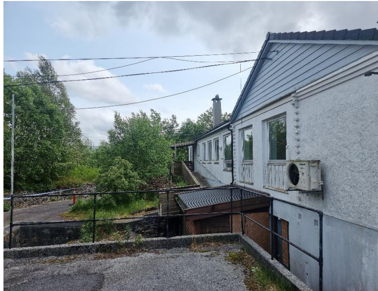
Figur 4-21 Fasade mot nordøst. Her var det opprinnelig ment å komme et påbygg med kontor og ekspedisjon øverst, og varelevering i kjelleren. Isteden har det i senere tid blitt satt opp en bod og en gangbro til og fra kjøkkenet. Bilderetning SØ.
