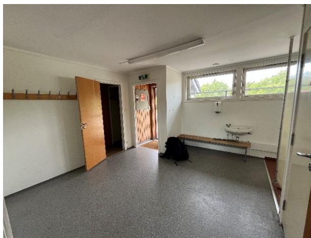
Figur 4-70 Garderobe, ved den vestlige inngangen
