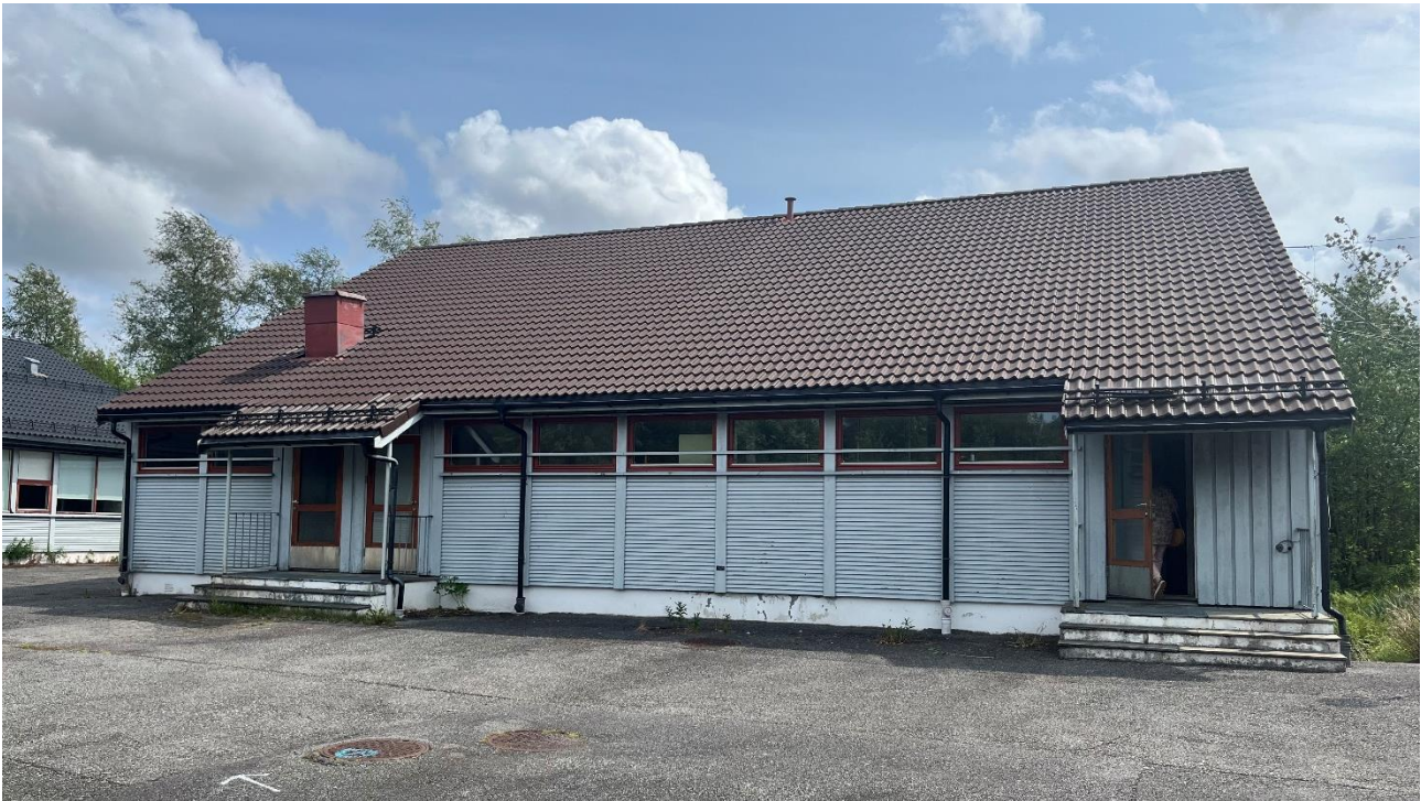
Figur 4-64 Fasade mot nordvest. Bilderetning Ø. Fasaden bærer preg av lite endringer over tid.
