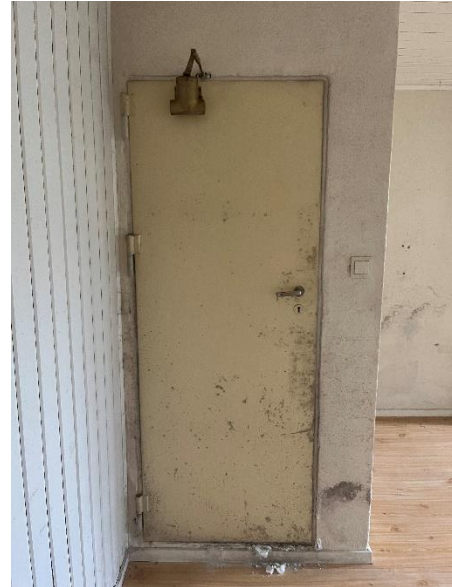
Figur 4-62 Brannør til trappehus mellom tilfluktsrommet og hovedetasjen.
