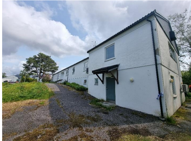
Figur 4-15 Fra fasade mot nordvest. Døren var stengt under befarings. Denne delen ble påbygd ca. 1973. Bilderetning SØ.
