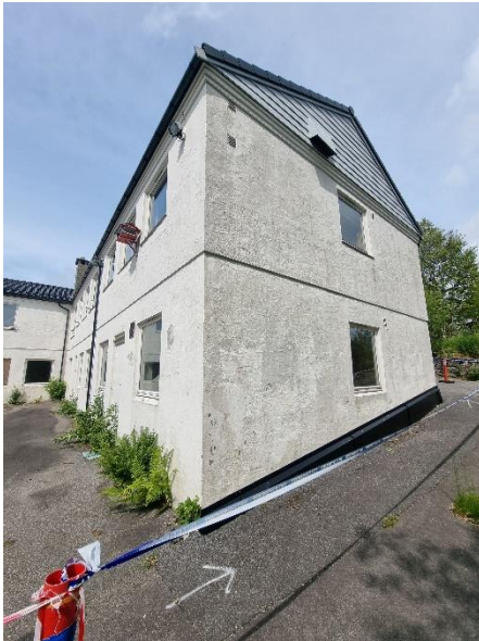
Figur 4-20 Fra enden av kjøkkenene i den fløyen mot øst. Bilderetning N.
