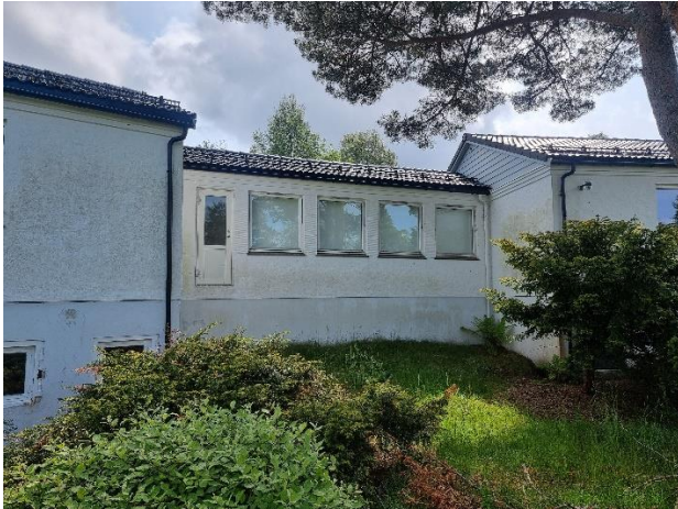
Figur 4-14 Passasje mellom de to paviljongene. Bilderetning S.
