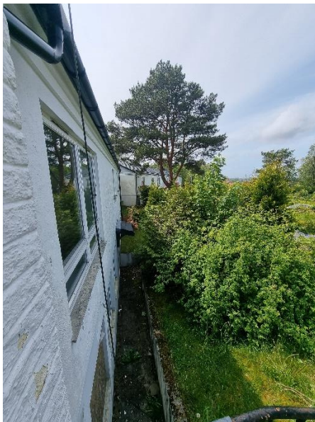
Figur 4-12 Blikk på fasaden sett fra hovedinngangsparti. Bilderetning sørvest. Legg merke til at takutstikk over kjellerdøren er det samme som man ser på bilde fra 1968 (Figur 3-3)
