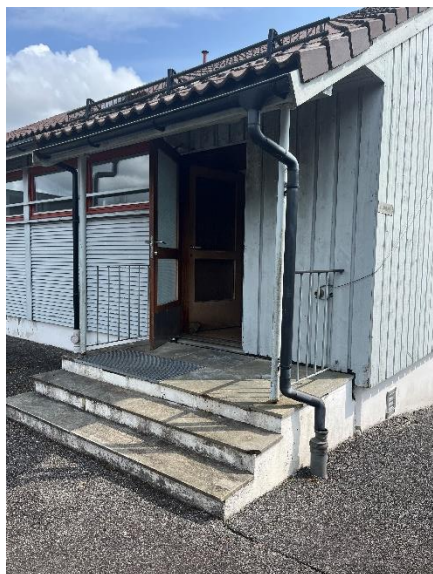
Figur 4-66 Hovedinngang gymsal, med trapp av skifer
