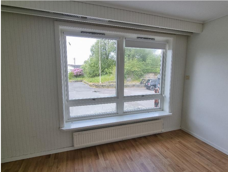
Figur 4-25 Fra nåværende gang/vindfang innenfor hovedinngangen. Blikk på parkeringsplassen utenfor, bilderetning NNV.
