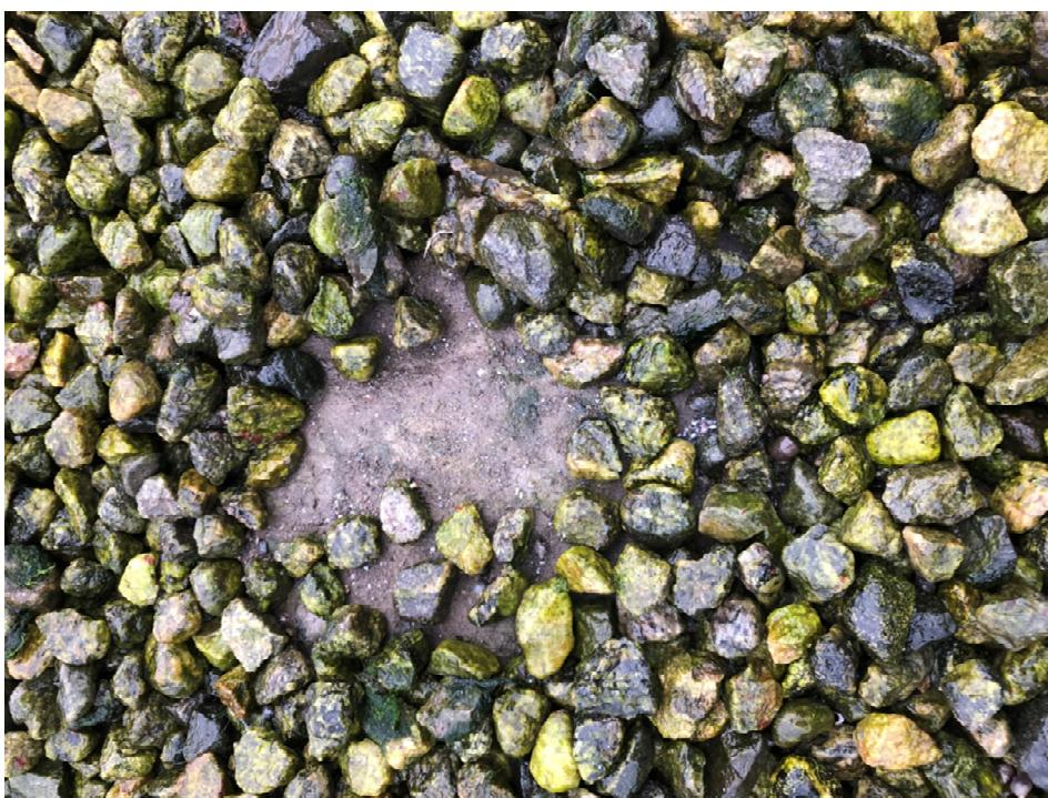
Figur 8: Erosjonssikring av naturgrus ligger stedvis tynt over reaktiv matte.
