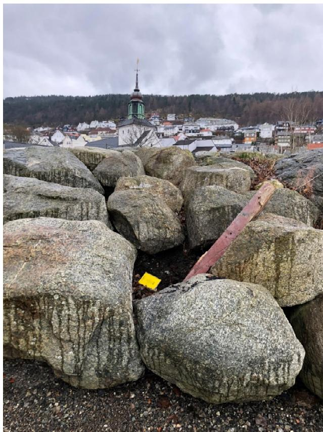
Figur 21: Felt i blokkskråning med jord (markert med gul notatbok) som anbefales stabilisert med en blokk og tildekket med masser.
