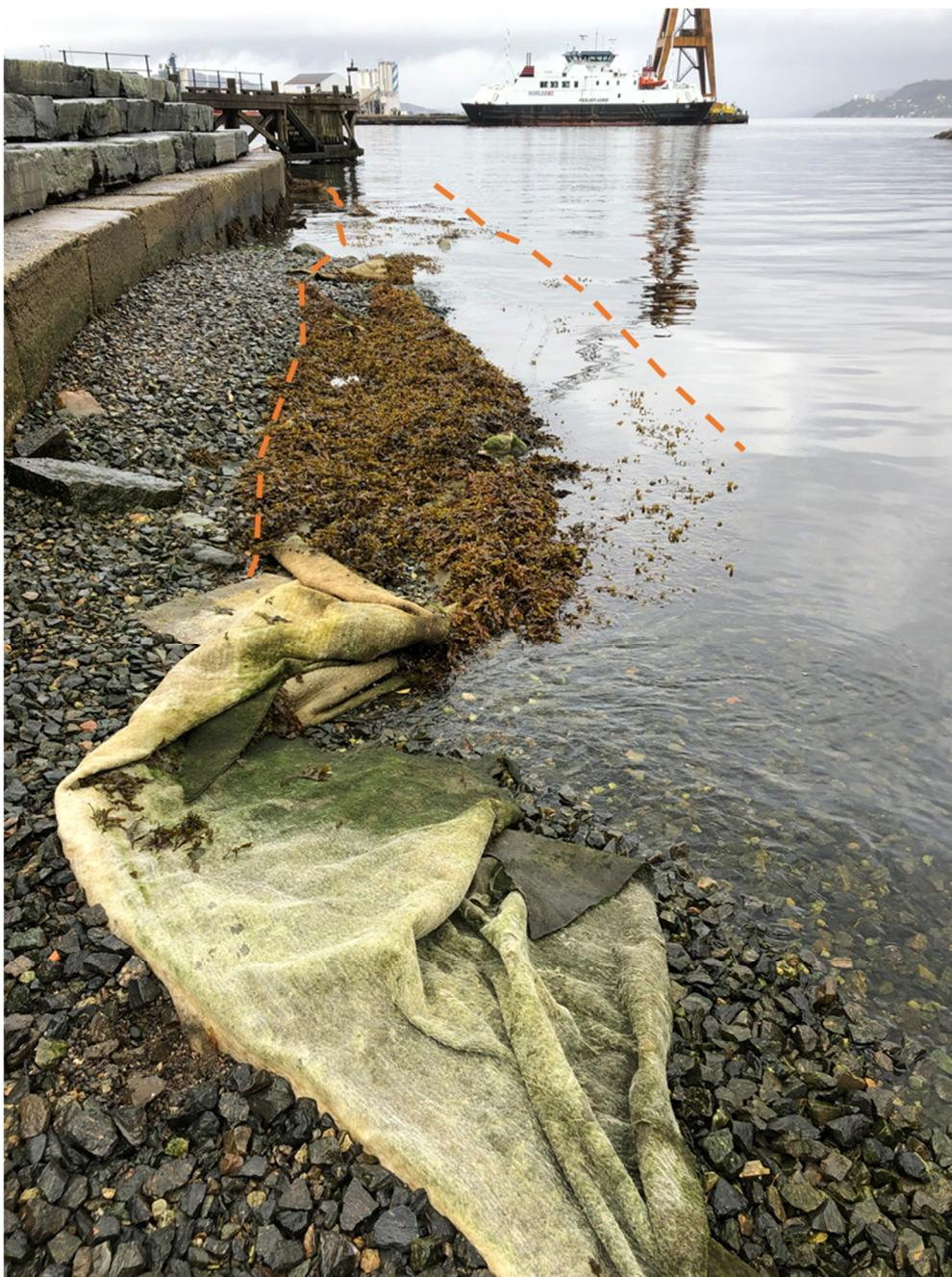
Figur 10: Eksponert matte langs steintrappene, oransje stiplete linjer markerer plassering av den delvis løse matten.
