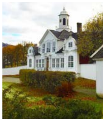
Damsgård hovedgård er symmetrisk utformet i volum og arkitektonisk uttrykk. Damsgård hovedgård har ord på seg for å være den best bevarte trebygning i Europa, og anses for å være et av de norske hovedverkene innen perioden rokokko.
