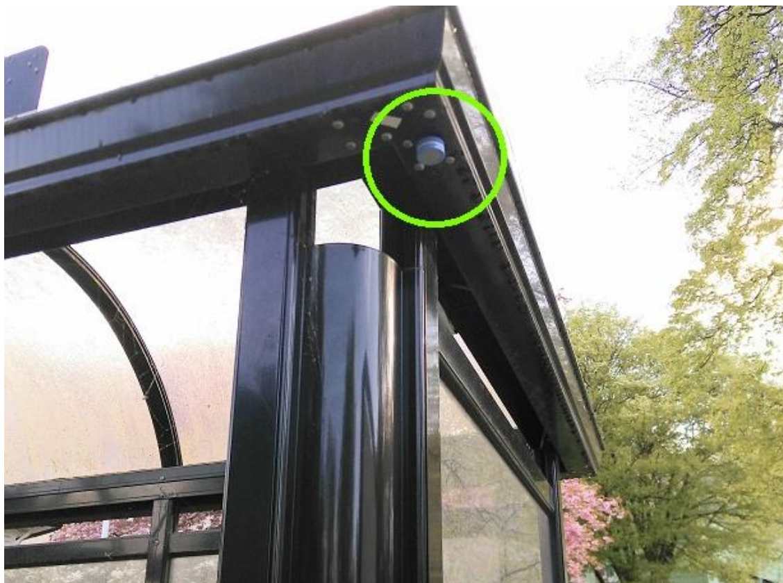
Figur 8.3 Passivmåler. Foto: Bergen kommune – Vitali Koudriavtsev
