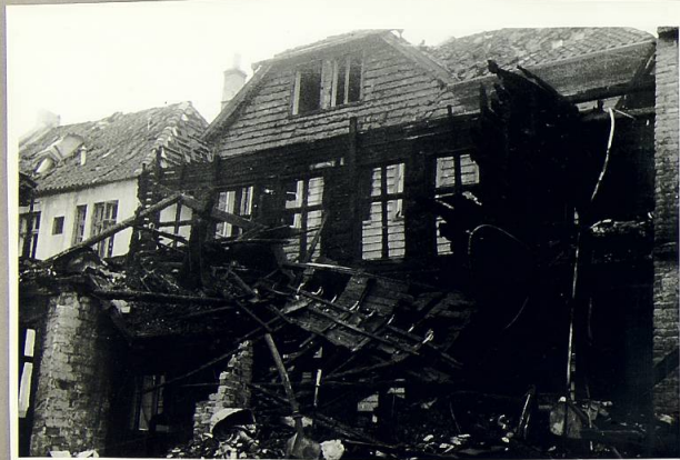
Husene ramlet sammen av lufttrykk
