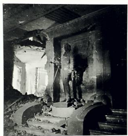
Ole Brüll stod helt uskadd i hallen, mellom nedstyrtte vegger og tak.
