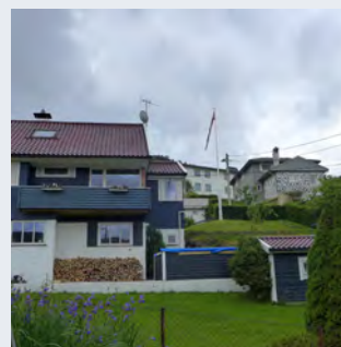
Eksempel på en bygningsstruktur som preges av en blanding av hageby og villabebyggelse, med god terrengtilpasning.
