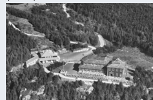
Fløybanens øverste stasjon, Fløyrestauranten og Verkstedet. De tegnet av Einar Oscar Schou
