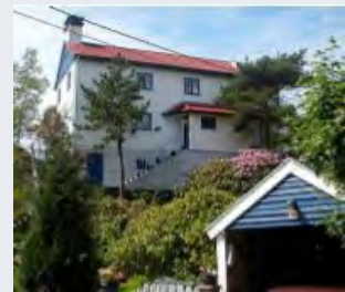
Gjennomgående høy kvalitet i arkitektur og terrengtilpasning preger alle utbyggingsfasene.
