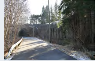
Gamle vossebanen med støyskjerming mot Jacob Kjødes vei 17.
