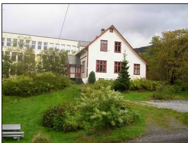
Figur 16: (Stephansens veg 33) Direktørboligen fra 1894 i sveitserstil. Denne ble bygget samtidig med den eldste fabrikkbygningen og arbeiderboligen. Huset er i god stand med originale vinduer og dør (foto: Byantikvaren).
