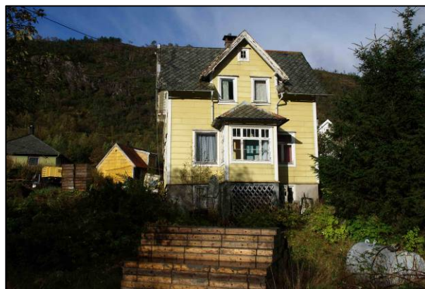
Figur 21: (Stephansens veg 94) Bygning i sveitserstil på Stolpareset. Huset er bygget i 1924. Huset er kledd i etanittplater (ikke originalt) og har en kombinasjon av originale og uoriginale vindu (foto: Byantikvaren).
