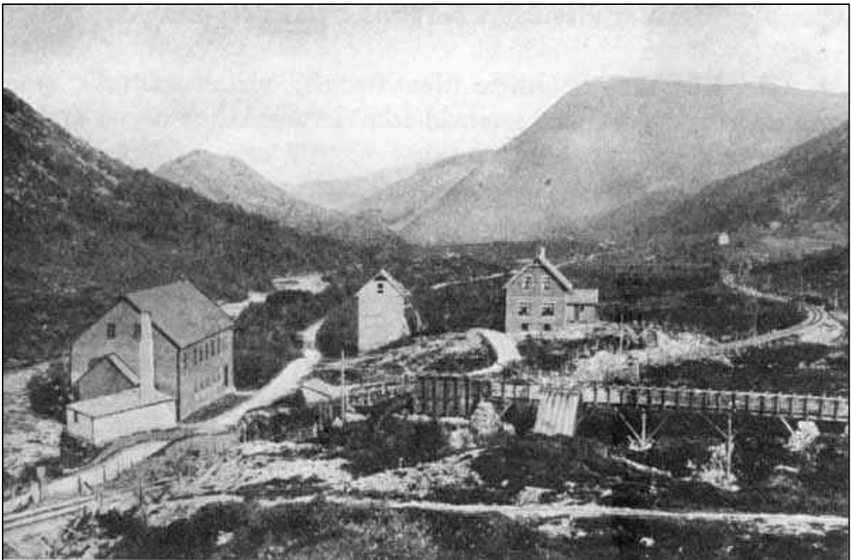
Figur 12: Fotografi fra 1895. Den første fabrikkbygningen ligger lengst til venstre. Direktørboligen ligger til høyre, mens arbeiderboligen står i midten. Arbeiderboligen ble revet i 1934 (foto: ukjent).
