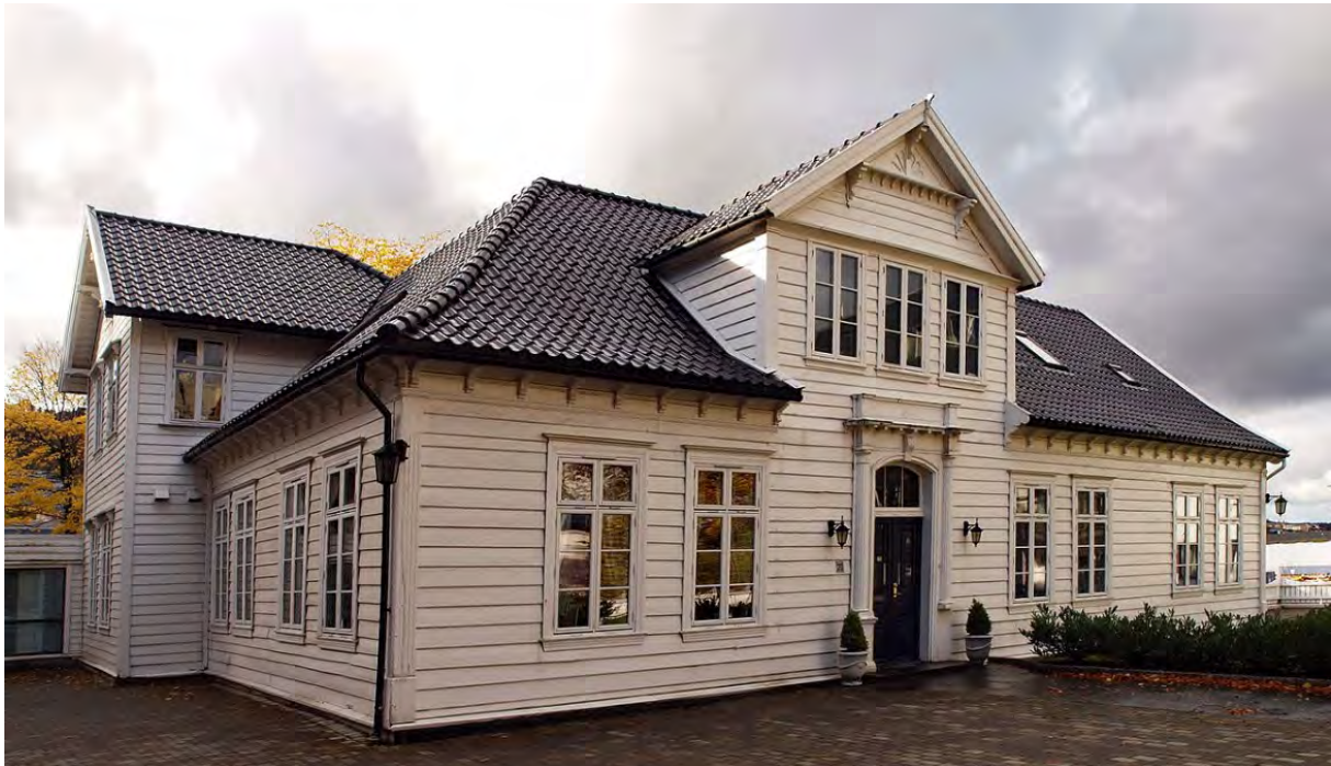
Figur 23: Hovedbygningen til Møhlenpris hovedgård, oppført i 1680, er bevart like under Puddefjordsbroens østlige brofeste (Foto: Frode Inge Helland 2012).
