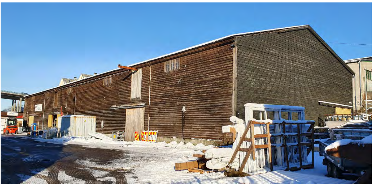
Figur 41: Skur 26 (Fjordgaten 5) er oppført av den tyske okkupasjonsmakten under 2. verdenskrig og er å betrakte som et krigsminne (foto: Byantikvaren 2021).
