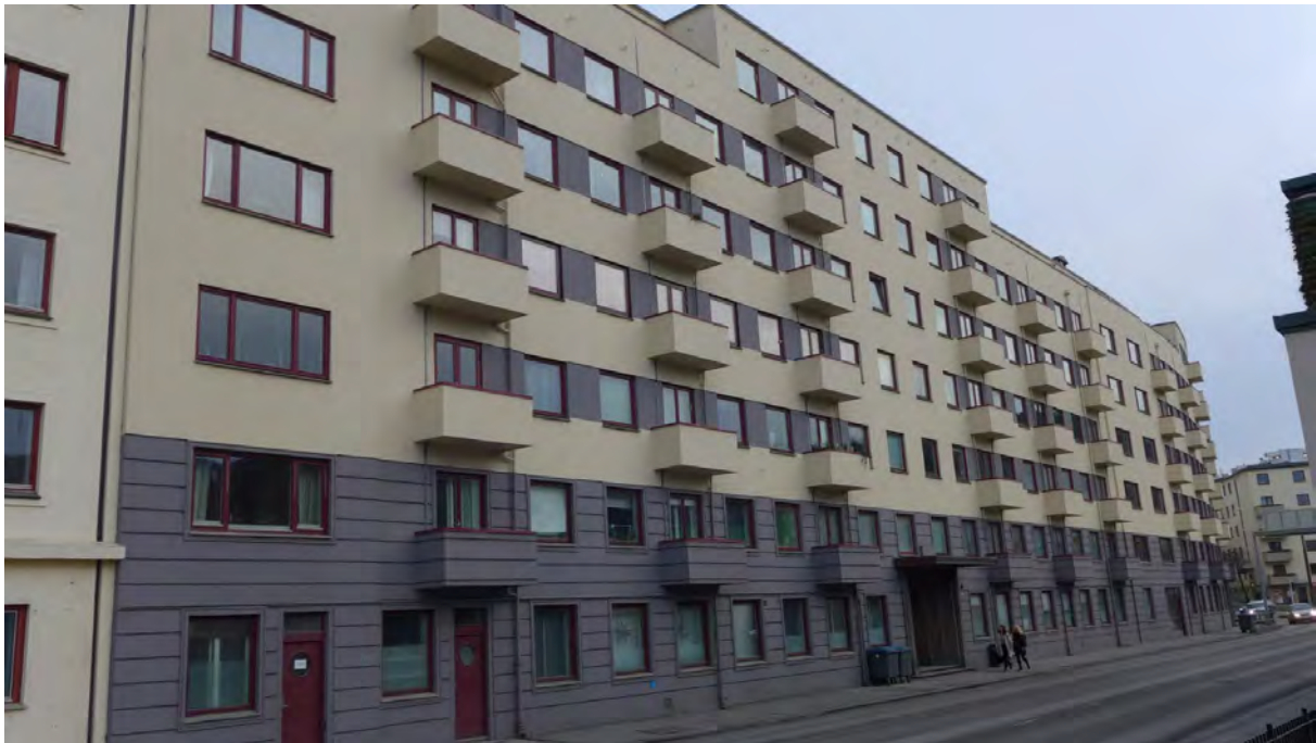
Figur 26: Boligblokkene innerst i Jekteviken ble oppført på 1950-tallet og er en del av Dokkens havnekvartar. Boligblokkene er gode eksempler på tidstypisk etterkrigsarkitektur. Bygningen på bildet, Torborg Nedreaas gate 18-20, er tegnet av arkitekt Arent Greve (Foto: Byantikvaren 2018).
