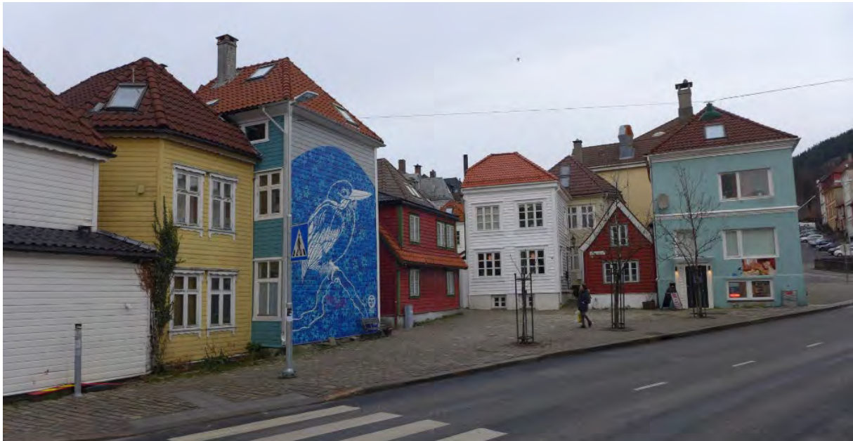
Figur 12: På tross av branner og nyreguleringer er fremdeles mye av det autentiske bygningsmiljøet i grendene ved Nøstebukten bevart. De kjennetegnes av et uregelmessig gatenett, tette sammenhengende bygningsstrukturer og mange små trehus. Bildet viser bygningsmiljøet nederst i Jonsvollsgaten (Foto: Byantikvaren 2018).
