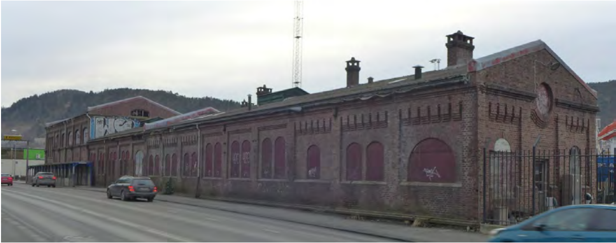
Figur 24: Den bevarte gassverkbygningen fra tidlig på 1900-tallet, Torborg Nedreaas gate 5, har høy verneverdi som er et typisk eksempel på industriarkitektur fra århundreskiftet (Foto: Byantikvaren 2018).
