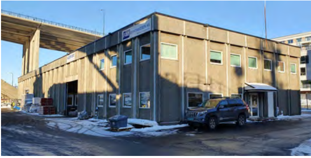
Figur 42: Mørerutenes terminalbygg (Møhlenpriskaien 8) oppført i 1974 (foto: Byantikvaren 2021).
