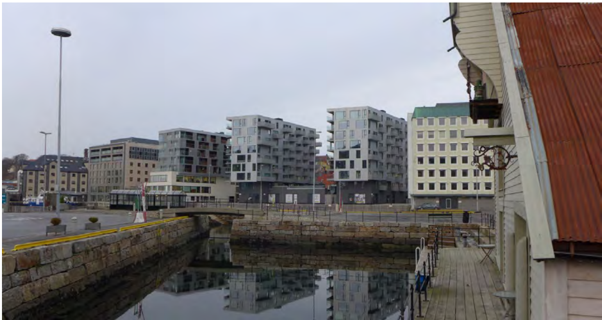
Figur 19: Oppføring av store moderne bygninger langs Nøstebuktens østside hindrer direkte kontakt med sjøen for den historiske bebyggelsen bak. Bildet er tatt fra Nøsteboden hvor det er etablert et kunstig basseng i kaiutfyllingene foran gavlveggen til boden (Foto: Byantikvaren 2018).
