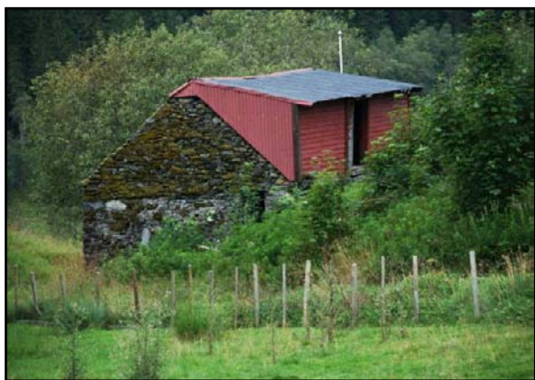
Figur 9: Steinbygd løe på Sætre, bnr. 2 (Foto: Byantikvaren 2010).
