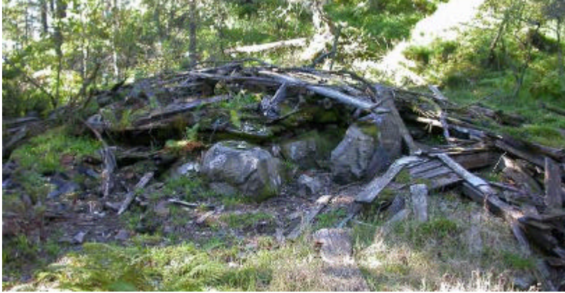
Figur 10 Nedfalt hytte ved jordhytten
